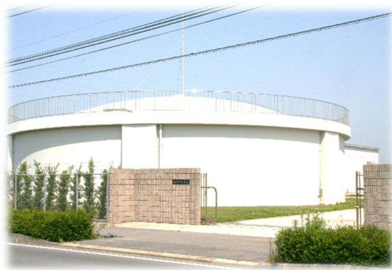
南沖野配水池
